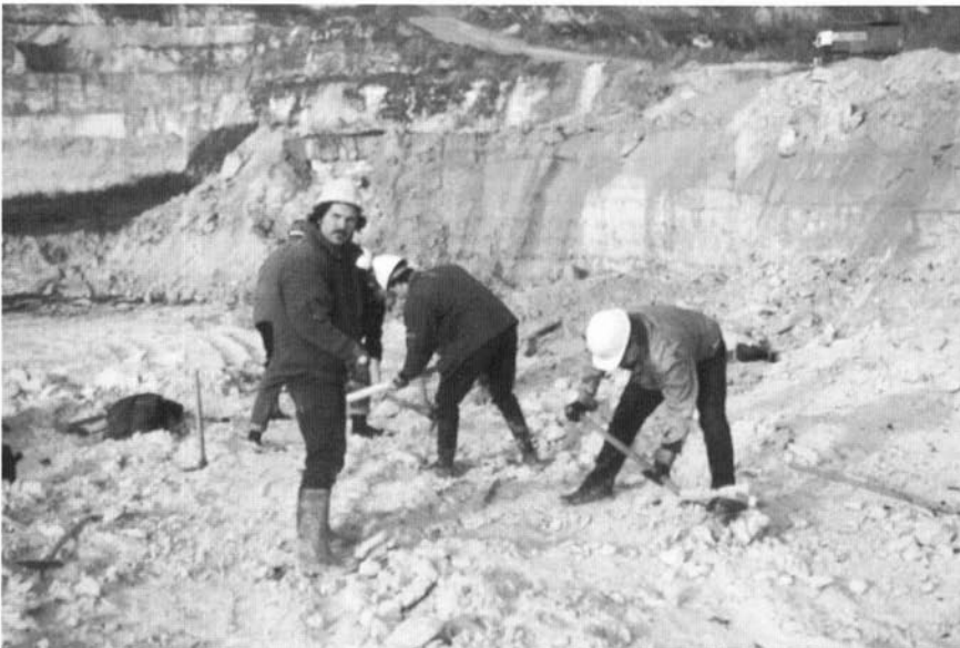
FIGUUR I Het terrein wordt vrijgemaakt (foto W.M. Felder).
