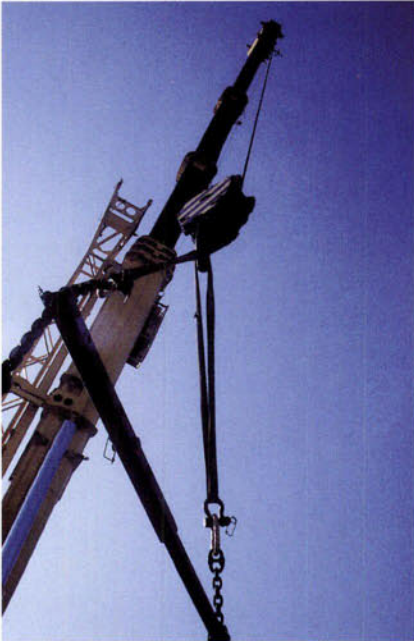
FIGUUR 3 Er was een mastlengte van 30 meter voor nodig om de Mosasaurus over het dak te hijsen.
