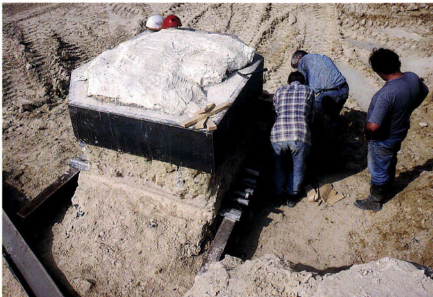
FIGUUR 1 Onder de stalen pijpen wordt een tweede staalconstructie gelast.
